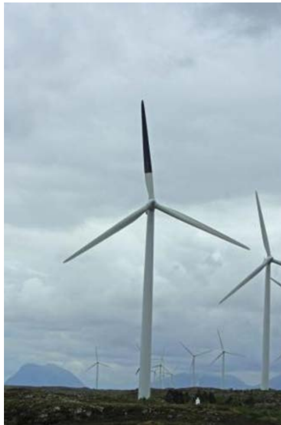
Aerogenerador en Smola (Noruega) con la pala pintada de negro
